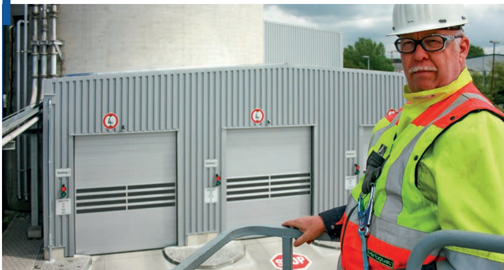
Die neue Einhausung in Duisburg
