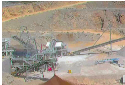
Klare Luft und Sicht sogar im Steinbruch durch einen optimierten Staubbiederschlag
